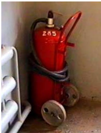
Рис. 7. Общий вид передвижного порошкового огнетушителя ОП-50(3):
